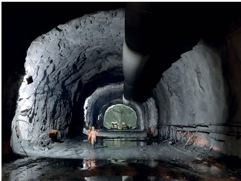
Figura 2. Tramo autosoportante del túnel vial de La Quiebra en Antioquia, Colombia (situación actual)
