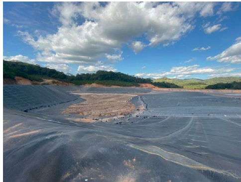
Fotografía 4. Sitio de la presa San José en Bonanza, Nicaragua, donde se impermeabilizaron 350.000 m 2 de terreno con geomembrana
