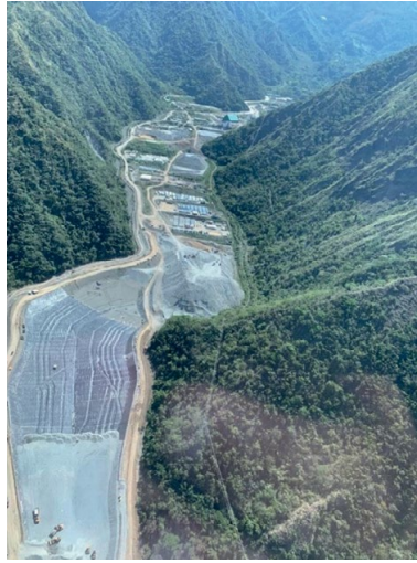
Fotografía 3. Vista del proyecto Buritica, en donde se observan las obras de infraestructura y la actual disposición de estériles
