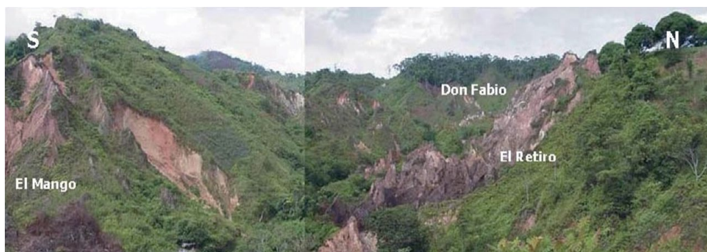
Fotografía 2. Ladera oeste del cerro Gramalote. Se observa el estado de intervención en que se encontraba el área en 1996, producto de una minería superficial sobre saprolitos con venillas de cuarzo aurífero, ejercida sin control y con muy mal manejo de estériles, depositados sobre las laderas
