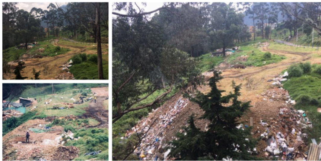
Figura 5. Fases de desmonte, camuflado con pasto cortado y relleno con desechos de construcción y otros materiales, para la producción de lotes a urbanizar (franja de adecuación Pardo Rubio, dirección norte)
