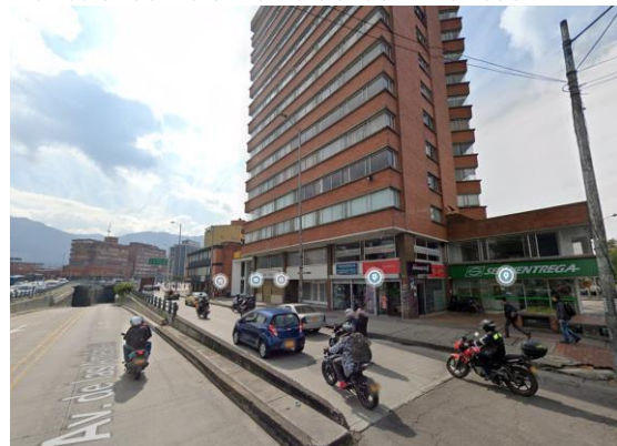
Imagen 8. Detalle de las condiciones viales frente al edificio ‘Torre de las Américas’
