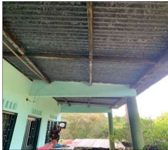
Figura 18 Estructura del techo de la casa
