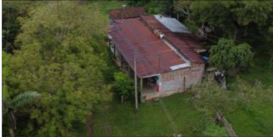
Figura 28 Área del techo de la casa finca Villa Mercedes
