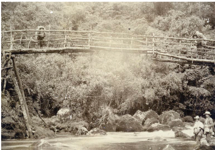
Figura 6.3. Carguero en un puente del piedemonte del Caquetá-Putumayo
