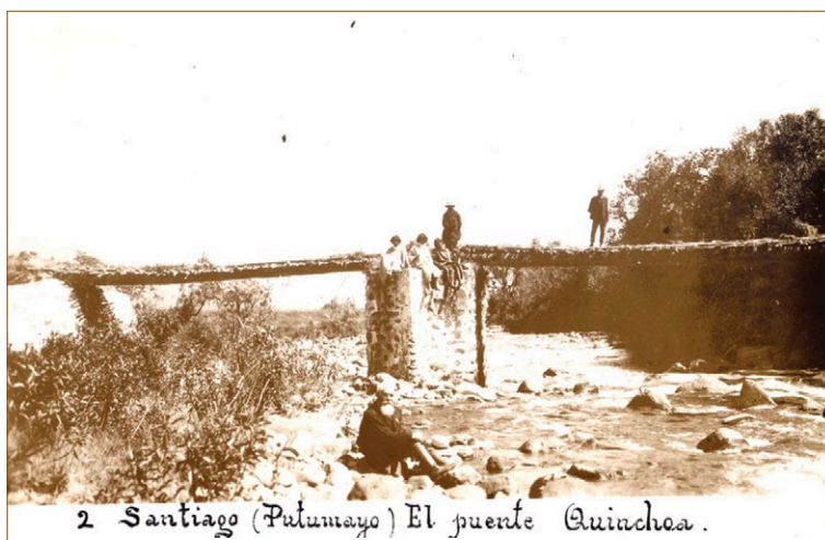
Figura 6.4. Puente de Santiago en el valle de Sibundoy
