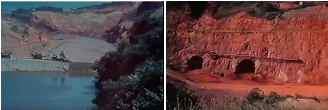
Imagen 4. 20 de enero de 1983. Cierre definitivo del cauce del Río Magdalena y túneles de desviación. Imagen extraída del documental Central Hidroeléctrica de Betania. Min 9: 37 y min 2:55. Recuperado de: https://www.youtube.com/watch?v=7V25bHlml-s
