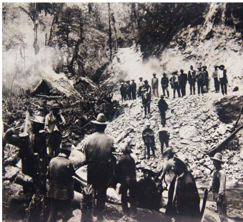
↑ Obreros trabajando en la sección San Francisco-Mocoa, c. 1911.
