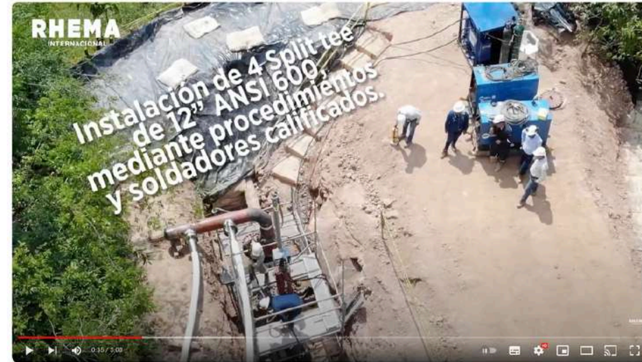
ATENCIÓN DE EMERGENCIA EN EL GASODUCTO CUSIANA – APIAY
