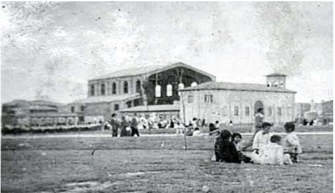
14. Iglesia y Capilla del Claret en Construcción, 1945
