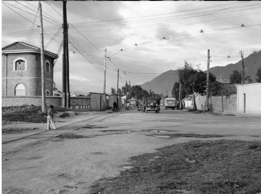
Arriba 12. Actividad de construcción de ladrillos en los chircales cerca al Río Tunjuelito.
