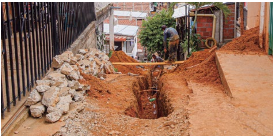
Fotografías 8 y 9. Instalación de redes de Emcali para acueducto y alcantarillado Fuente: Gynna Millán, 2022.
