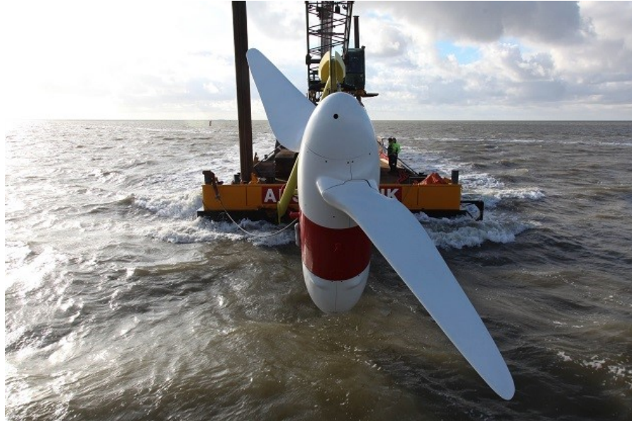
Figura 32. Turbina mareomotriz de eje horizontal Tocardo T-1 durante instalación. Fuente: (QED Naval Limited, 2026). Recuperado de https://qednaval.co.uk/technology/
