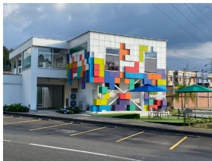
Figura 12 Construcción del Cubo de Innovación
