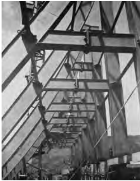
Construcción del edificio Coltejer, tomado de Lanzadera , n.º 1 (julio-agosto de 1971).
