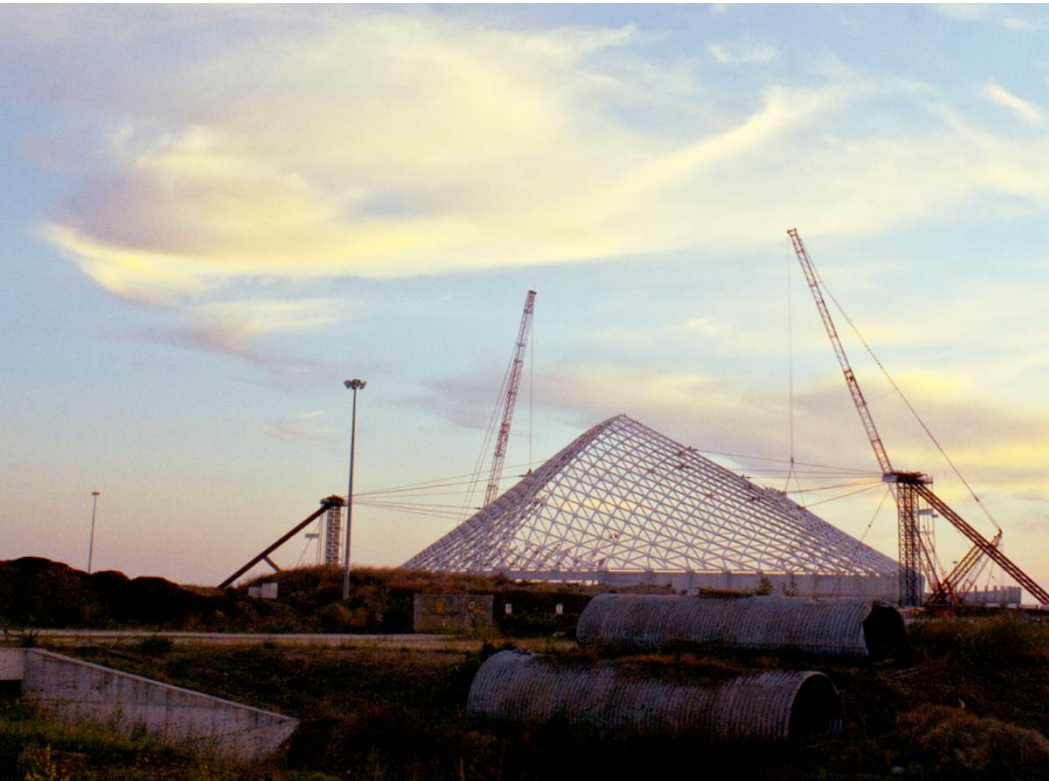
Ciudad Deportiva, Santiago Calatrava (comenzó en 2007)
