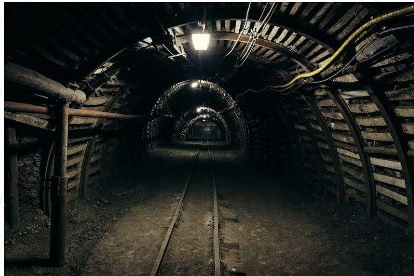
INSTALACION DE ILUMINACION
