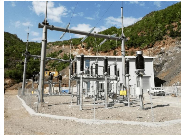
INSTALACION PLANTA MECANICA
