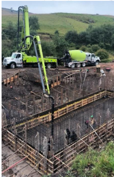
PLACAS DE CONCRETO
