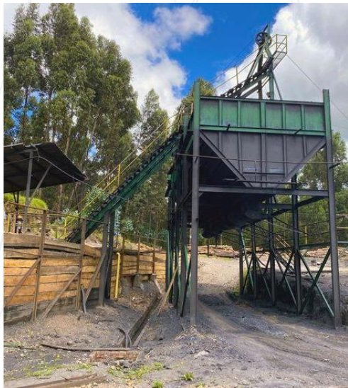
TOLVA DE CARGA
