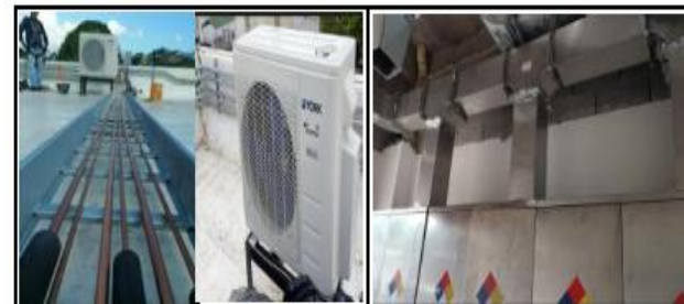
Comisionamiento de sistema de aires acondicionados de laboratorio.
