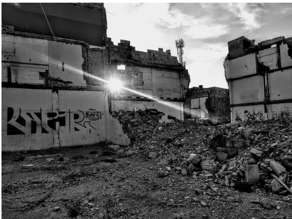
Foto 1 Clavijo, L (2021). Demolición de predios en Cassandra.
