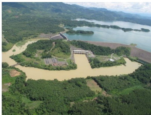
Imagen 7. Fotografía panorámica de la Represa Hidroeléctrica Urrá. (Fuente: Sitio Web de Urrá): https://urra.com.co/ .
