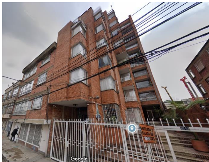
Imagen 10. Edificación de 10 pisos de altura destinada a vivienda
