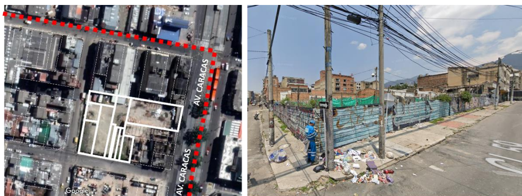
Imagen 7. Uso de parqueaderos (planta y fachada) en la manzana catastral 5
