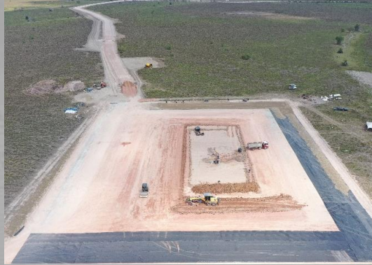
Instalación de subbase granular en plataforma
