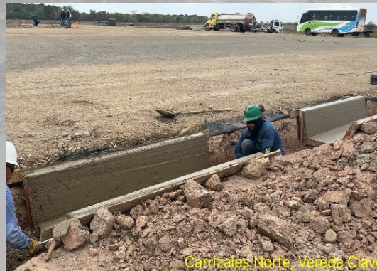
Construcción de cunetas de aguas lluvias
