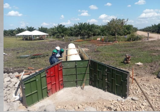
Construcción de Alcantarilla No. 1 Abscisa 0+000
