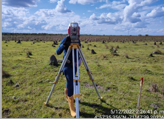
Levantamiento topográfico y replanteo de áreas
