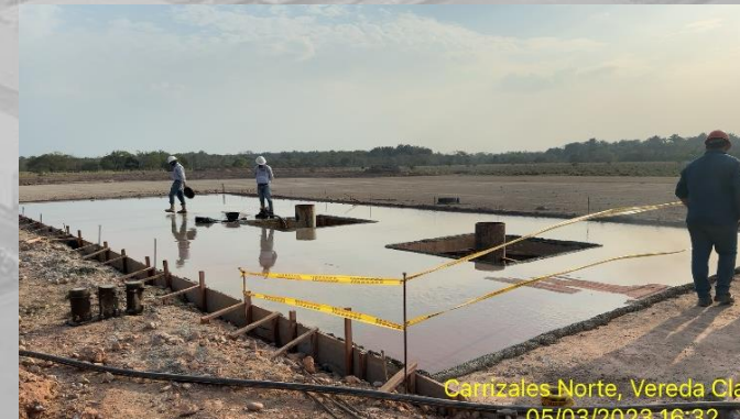
Vaciado de concreto 3000 PSI para placa taladro
