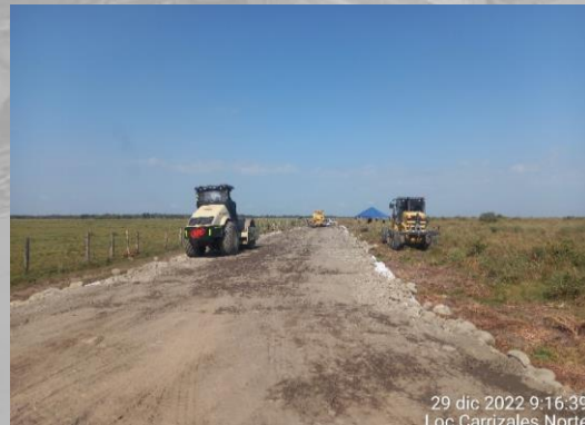
Compactación crudo de río en vía de acceso PK 0+000 al PK 4+000
