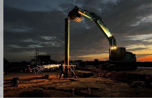
Izaje e instalación de tubo conductor a 30m
