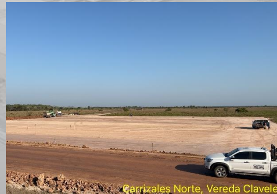
Conformación de terraplén con material de préstamo en plataforma
