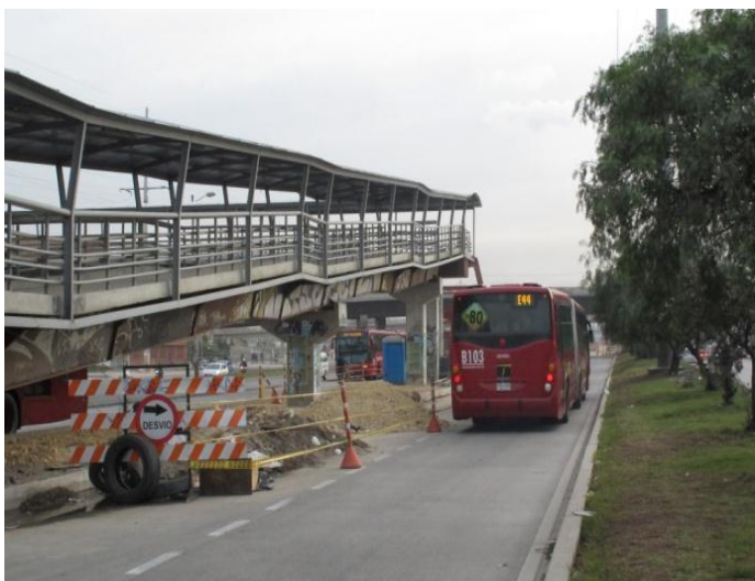
Puente en construcción para el acceso a la estación San Mateo desde la estación intermedia.
