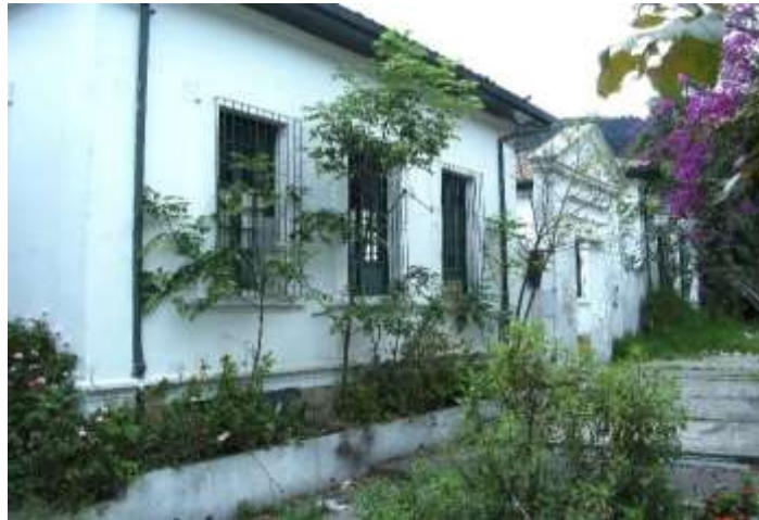
Ilustración 1 Costado sur antigua sede del Colegio distrital General Santander
