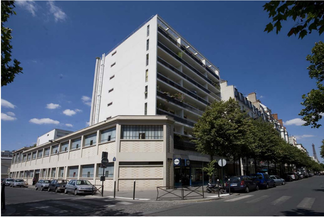
Fachada de la Casa de los Periodista sobre la calle Cauchy / Cortesía MDJ
