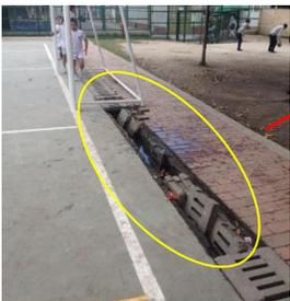
Ilustración 14 Rejillas en mal estado despiden **malos olores, afecta mucho (9)**
