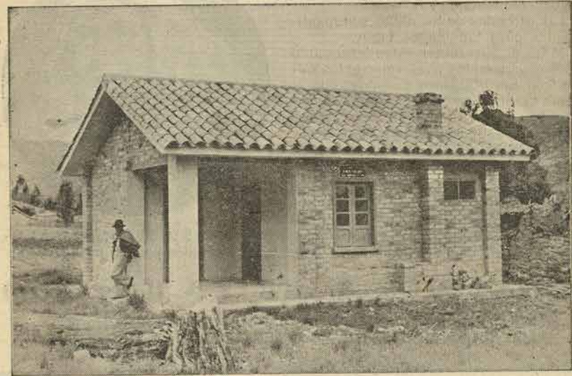
CASA PARA MAYORDOMO.—Tiene 2 alcobas de 3.50 x 3 mts. y 3 x 3, con alacenas; comedor de 3.50 x 3 mts.; depósito de 2.25 x 3 mts.; para granero o herramientas; cocina de 2.50 x 3 mts., con estufa.—Un pórtico de 2 x 3.10 mts.; otro de 2 x 2.60 metros. Construcción en ladrillo, cubierta de teja de barro; pisos de madera y cemento: Área construida, 63.70 metros cuadrados.—Provista de letrina.
